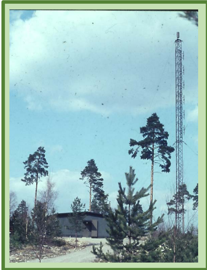
Sändaranläggning Fmr-10 (Styrdata)
